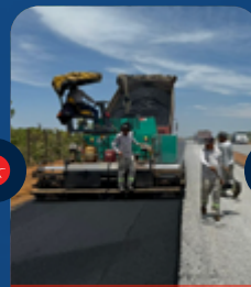
Pavimentação asfáltica
